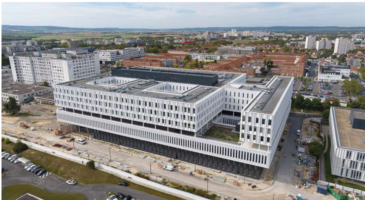
CHANTIER DU NOUVEL HÔPITAL - OCTOBRE 2023
